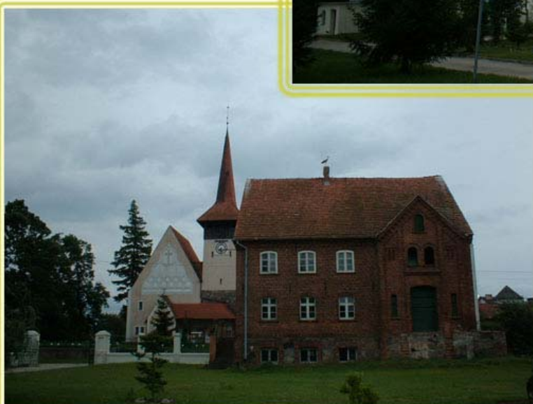
Fot. 1 Pałac wraz z zabudowaniami gospodarczymi w miejscowości Ojerzyce. Obecnie w pałacu mieści się hotel. Autor: Magdalena Stec
